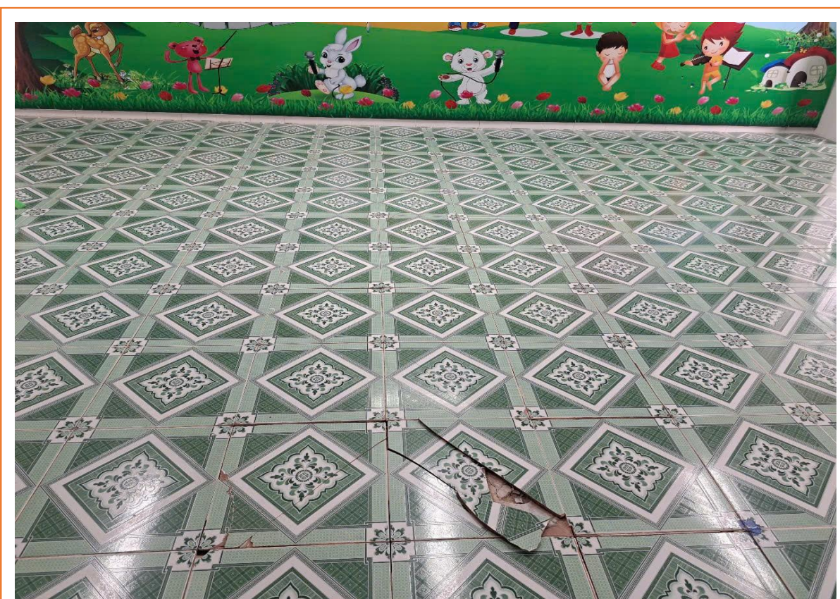
Hình ảnh: Nền nhà phòng âm nhạc khu B bị nứt, gãy
